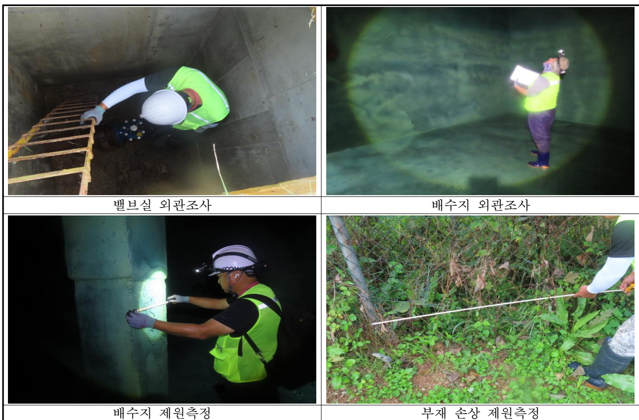
【사진 3.1】 시설물 외관조사
