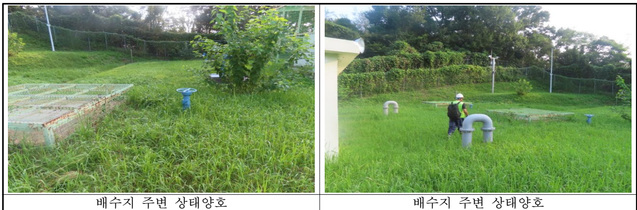
【사진 3.8】 기타 부대시설 손상사진
